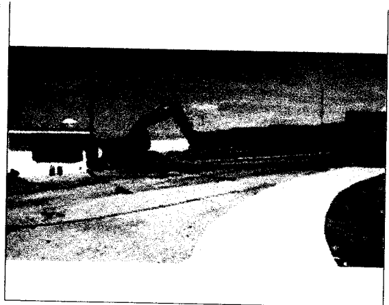
FOTO N° 64: ELIMINACION DE DESMONTE
