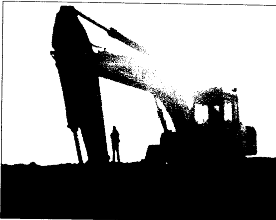
FOTO N° 51: INGRESO DE EXCADORA A ZONA DE DRAGADO
