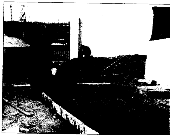
FOTO N° 18: COLOCACION DE VEREDAS
