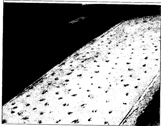
FOTO N° 16: PICADODE VEREDA EXISTENTE PARA LA COLOCACION DE ESTAS
