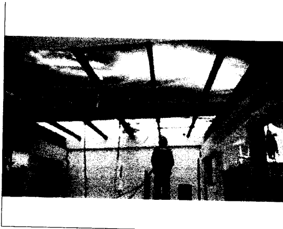
FOTO N° 63: COLOCACION DE POLICARBONATO
